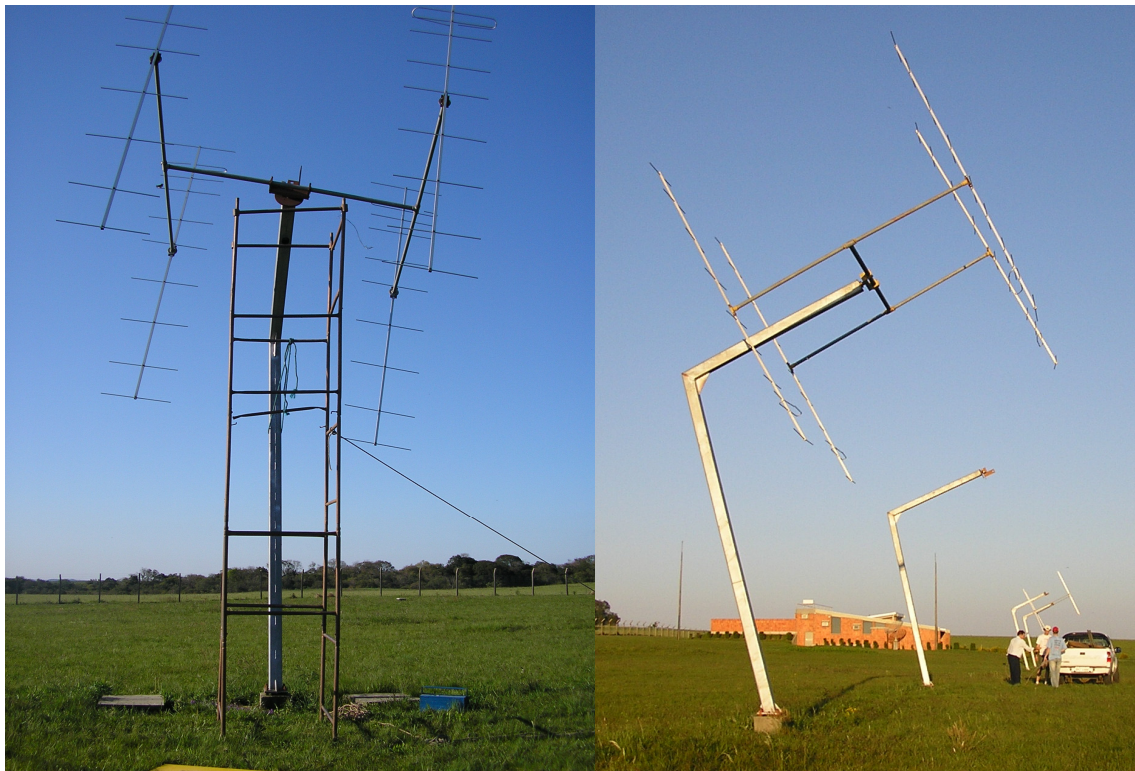
FIGURA 4.6 – Vista Panorâmica de estruturas coletoras parcialmente montadas no Observatório Espacial do Sul – OES/CRSPE/INPE – MCT, em São Martinho da Serra, RS.
